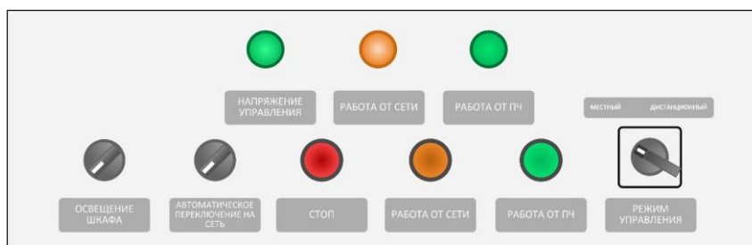
Рис. 6.8 - Панель управления системы автоматического байпаса
